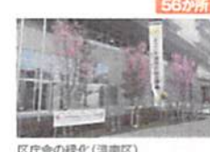
区庁舎の緑化(港南区)
